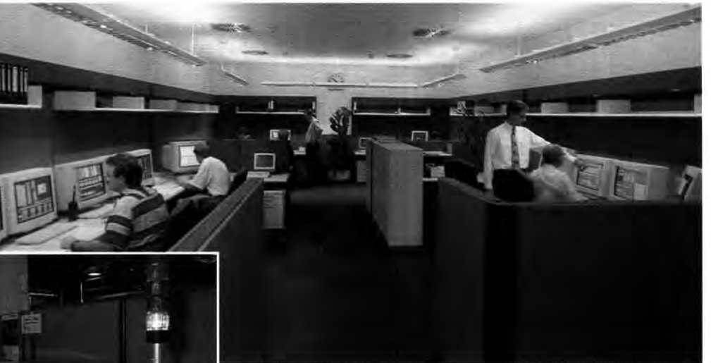
Schaltzentrale: Im Rechneraum laufen alle Fäden zusammen
