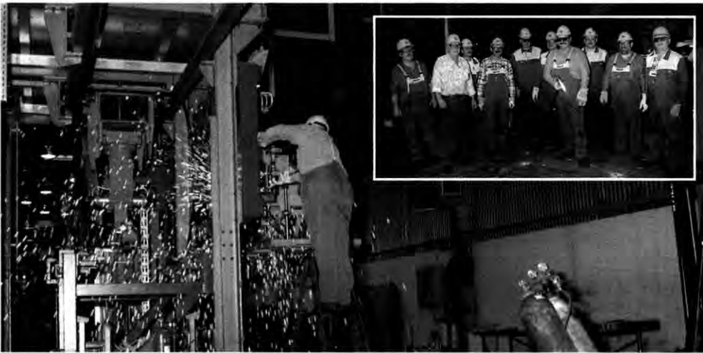
Im K 25 hat's gefunkt: Mitarbeiter führen die Ab- und Umbaumaßnahmen in Eigenregie durch
