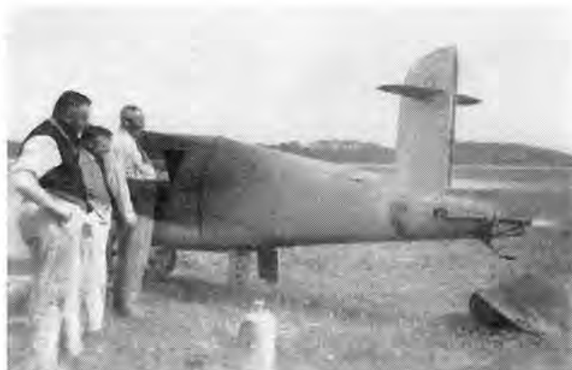
RAKETENKONSTRUKTEUR Ing. Fr. W. Sander (hinten) bereitet mit Versuchen an einem Flugzeugmodell den Raketenflug Fritz von Opel's vor, bei dem er am 30. September 1929 eine Geschwindigkeit von 150 km/h erzielte
