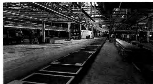
Ketten gesprengt: Der Umbau-Zeitplan wurde eingehalten
