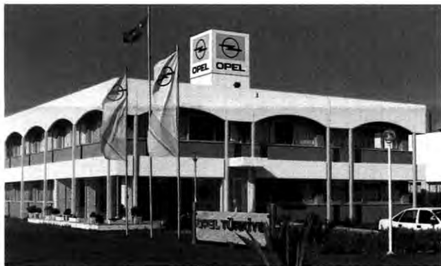
Heißes Haus: Torbali-Temperaturen von 42 Grad sind möglich
