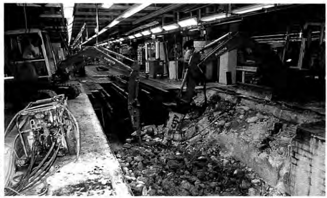
Bodenlos: Bei den Umbauten im K 40 mußte schweres Gerät ran
