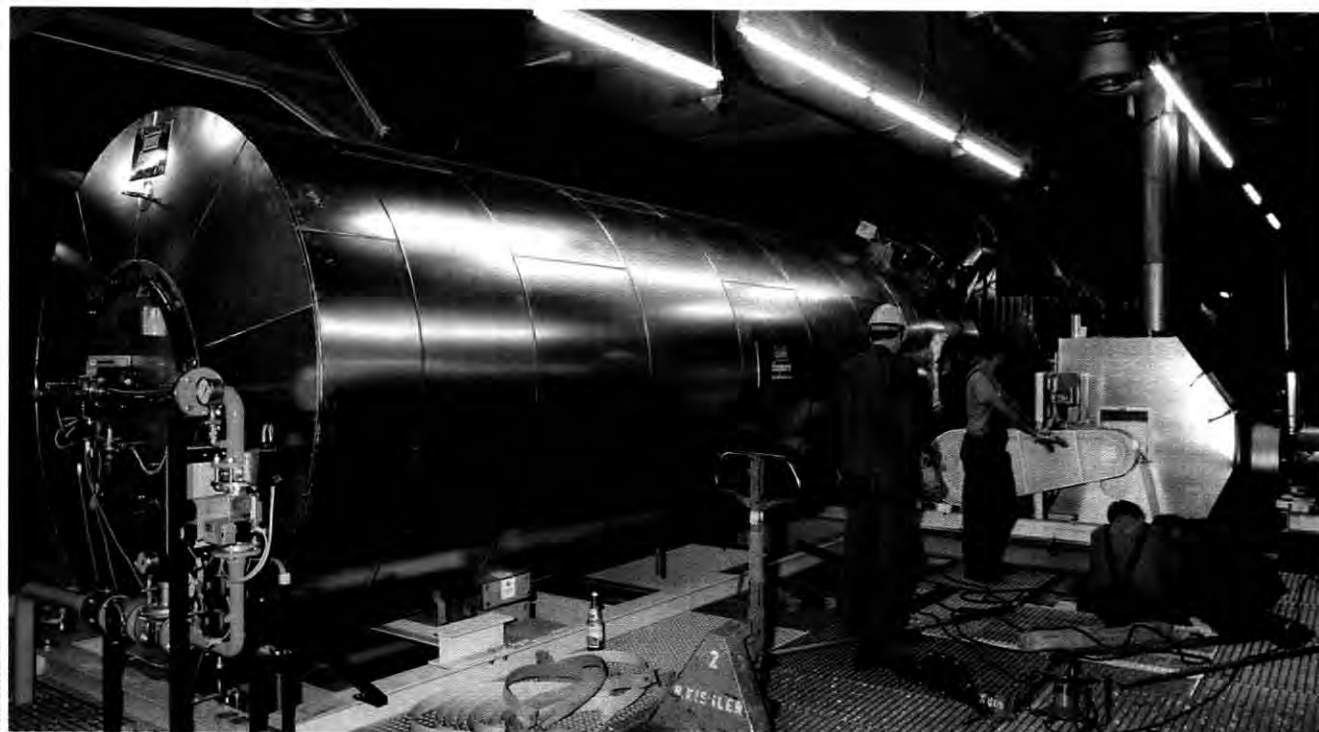
Bollerofen: Das Kernstück der Umbauten ist die Anlage zur thermischen Abluftreinigung, deren Brennkammern gewaltige Ausmaße haben
