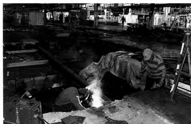
Ganze Arbeit: Selbst der Betonboden wurde nicht verschont
