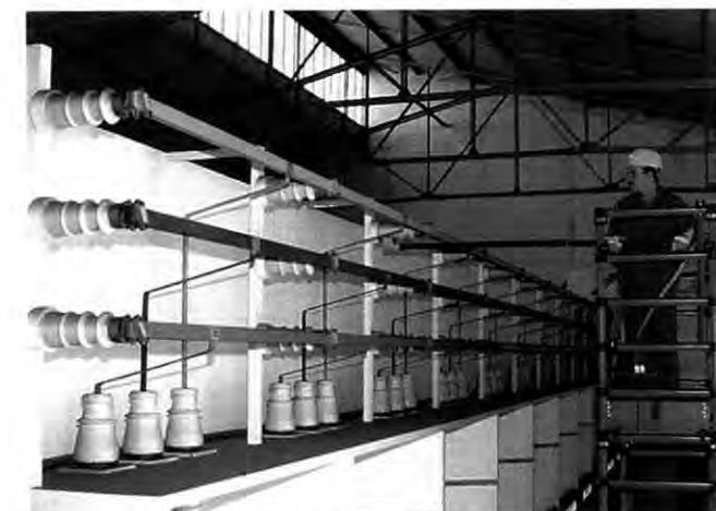
Spannend: Netzreinigung mit Glasgerüst und Iso-Staubsauger
