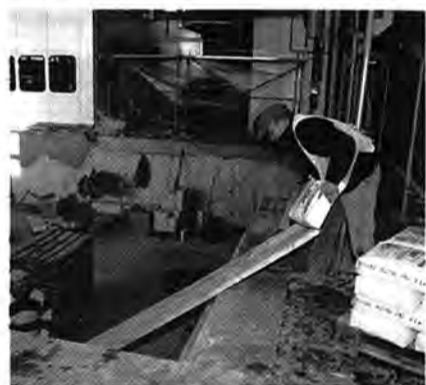
U-Bahn: Der Umbau fängt im Keller an
