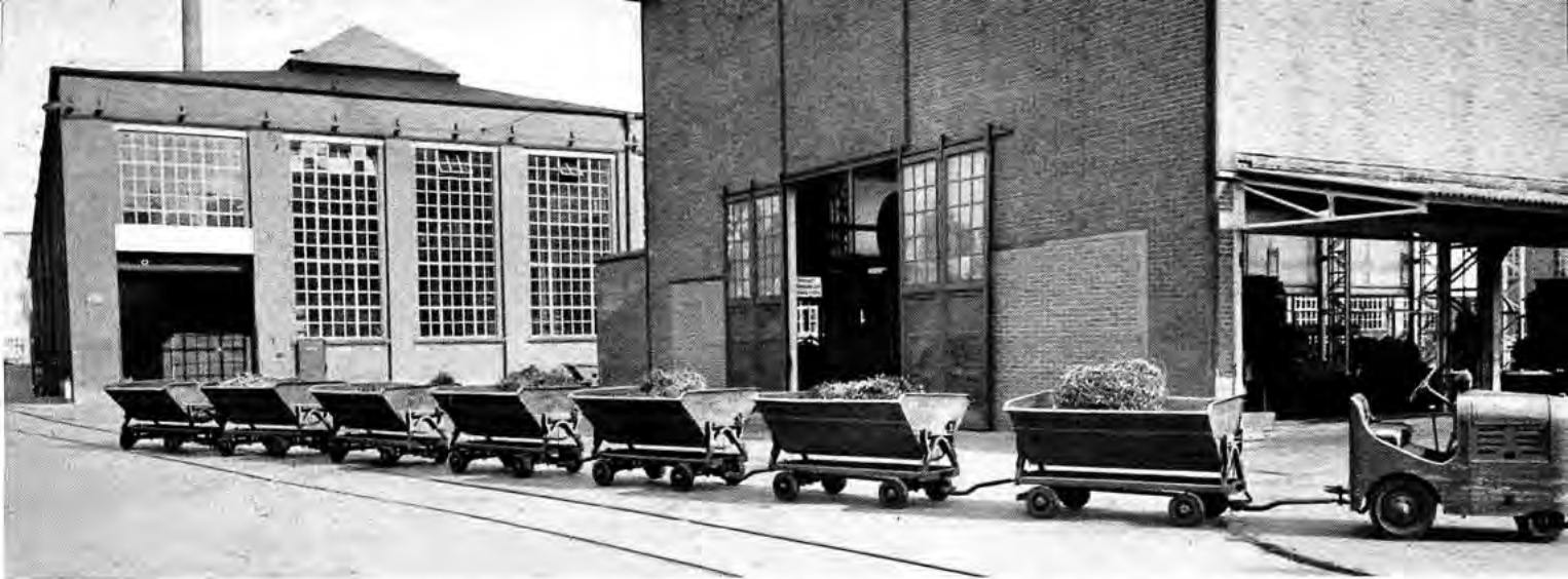
Neuzeitliche Zugmaschine mit besonders wendigen (vierradgelenkten) niederen Kippwagen beim Transport von Spänen.
