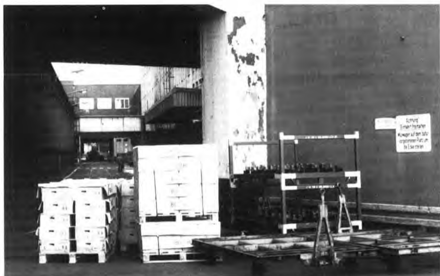
Durch gedankenlos abgestelltes Material wurde diese Werkstraße – wenn auch nur vorübergehend – für den Fahrzeugverkehr schwer passierbar gemacht. Problematisch würde es bei Feueralarm oder einem eiligen Krankentransport.
