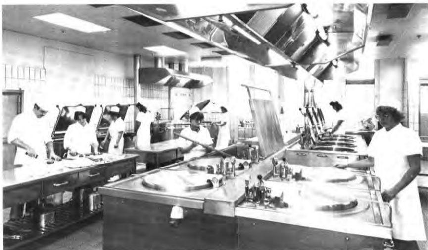
Blick in die neue, moderne Großküche unseres Werkes Kaiserslautern.
