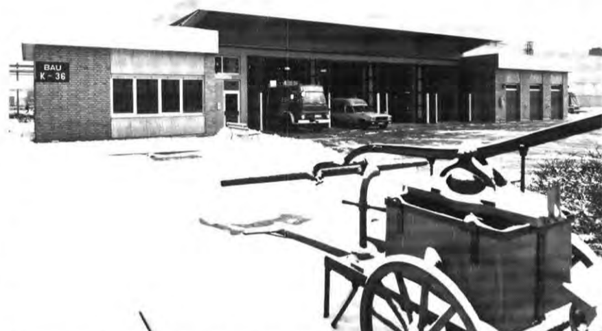
Unsere neue Feuerwehr. Der Neubau wurde zentral zwischen dem Bau K 20 und K 30 errichtet. Links erkennt man die Zentrale. Daneben ist die Fahrzeughalle und rechts der Werkstattbereich. (Die Aufnahme entstand im März, als es wieder einmal geschneit hatte.)
