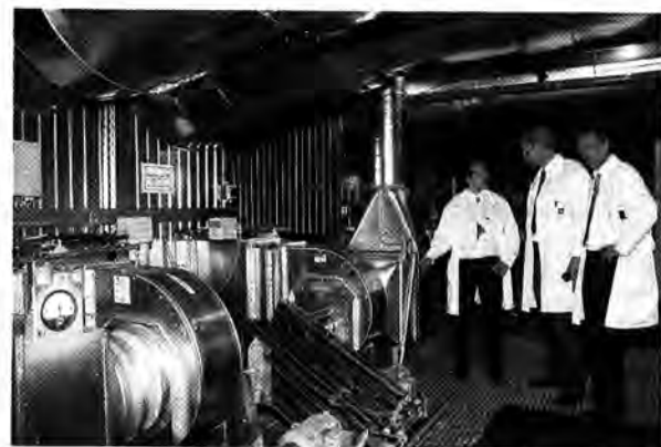
Manche mögen's heiß: Die Abluft erreicht Temperaturen von...
