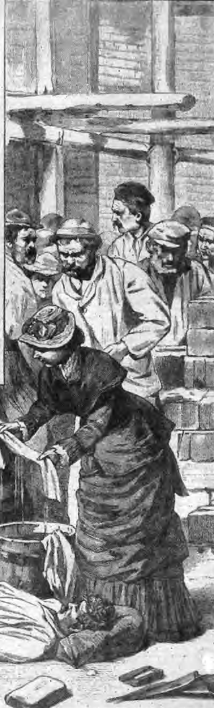
EINE SAMARITERIN leistet einem vom Gerüst gestürzten Bauarbeiter erste Hilfe. 1882 staunte man über solche Bilder. — Oben links: Professor Friedrich Esmarch, vor 80 Jahren Gründer der Samariterbewegung
