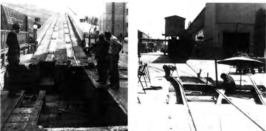
Reparaturen und Ausbesserungsarbeiten in Hallen und auf Straßen.
