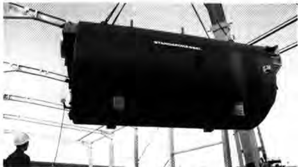
Kessellift: Die 56-Tonnen-Kessel brauchen einen kräftigen Kran
