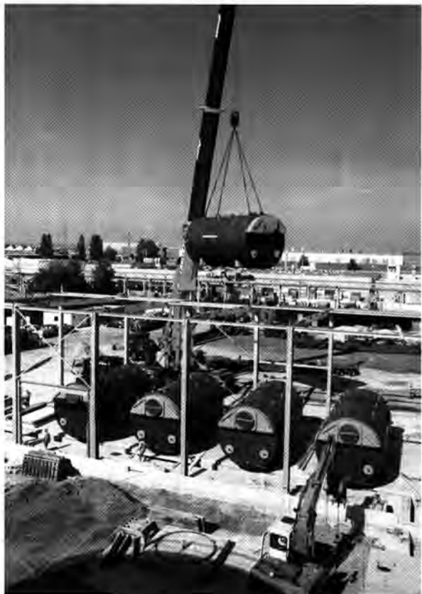
Aufgereiht: Die Kesselhaus-Konturen sind schon zu erkennen
