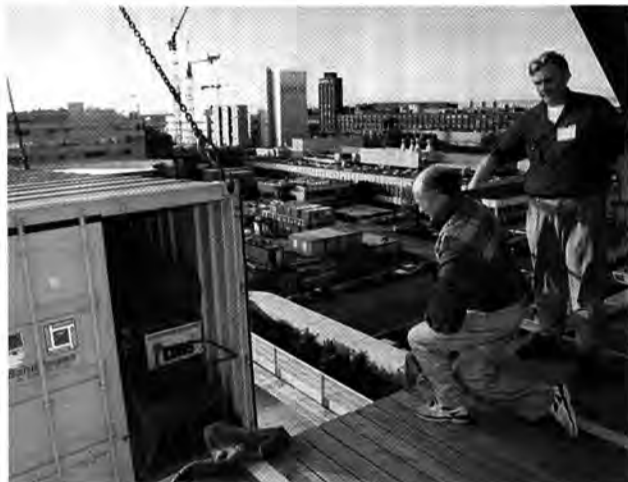
...Container verpackt, per Kran in die richtige Etage gehievt,...
