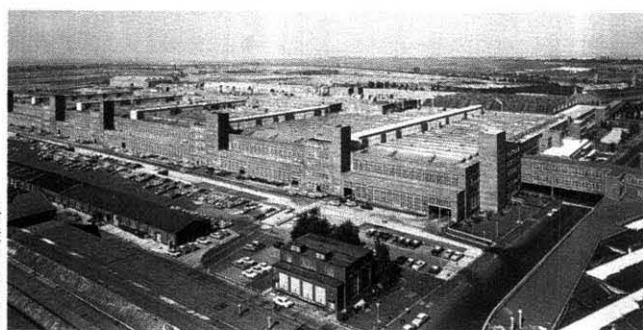
Herausforderung: Der Bau des K 40 prägte Arndts Berufsweg
