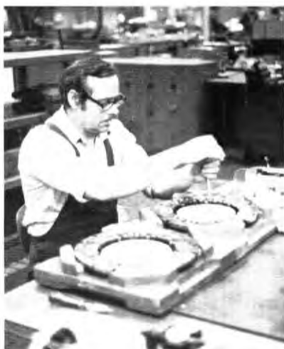
Links Mitarbeiter Bernward Dahlberger beim Neubestücken von Innenfräsern. Die Werkzeuge sind in der Kurbelwellenfertigung eingesetzt. — Rechts Mitarbeiter Werner Schindler beim Einstellen von Gewindestrehlern. Die Werkzeuge sind in der Fertigung Bolzen-Radlager für Kadett und Ascona im Einsatz.
