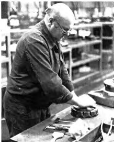
Mitarbeiter Karl Rech beim Bestücken eines Messerkopfes (linkes Bild). — Rechts Mitarbeiterin Edeltraud Gawenda beim Nachschleifen von Spiralbohrern an einer Kleinstbohrerschleifmaschine.
