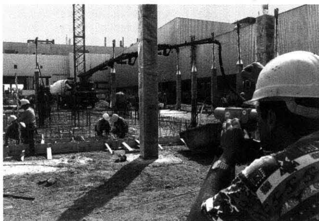
Bau nach Plan: 80 Kubikmeter Beton bilden das Fundament
