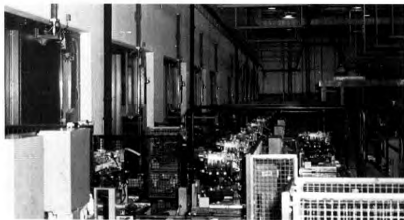
Blick in das Benzinmotor-Prüffeld unseres Werkes Kaiserslautern.
