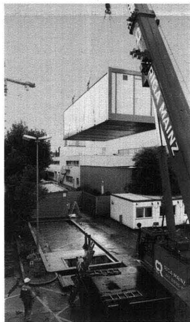
Am Haken: Die neue Strom-Station
