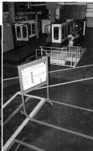
Letzte Vorbereitungen: Anfang des kommenden Jahres soll im Preßwerkzeugbau an vier Linien in fünf Takten gearbeitet werden
