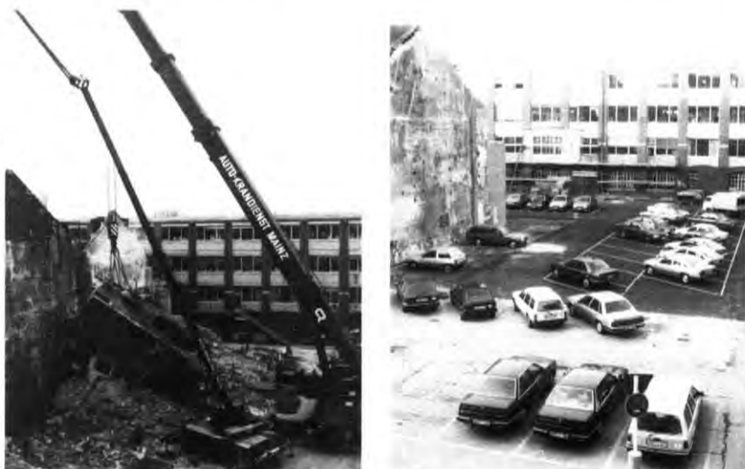
Ende vergangenen Jahres wurde mit dem Abriß des alten Kesselhauses in der Nähe des Hauptportals begonnen. Inzwischen ist dort eine große Freifläche entstanden, die in einen Parkplatz umgewandelt wurde, der in diesem stark frequentierten Bereich des Werkes dringend notwendig war.
