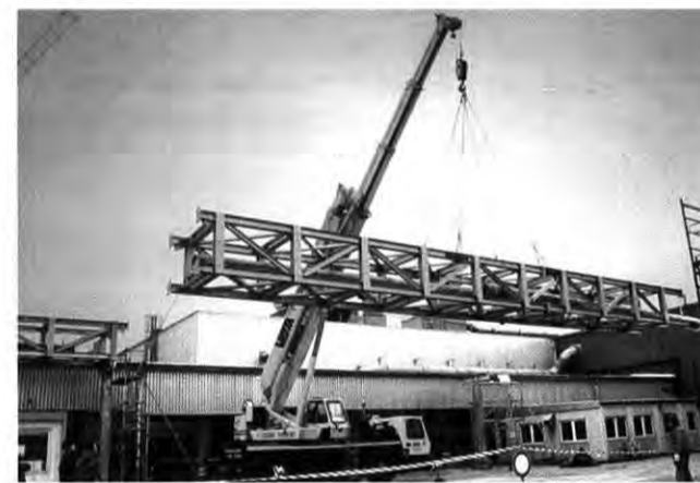
Luftig: Mit der Rohrbrücke schreitet die Modernisierung voran
