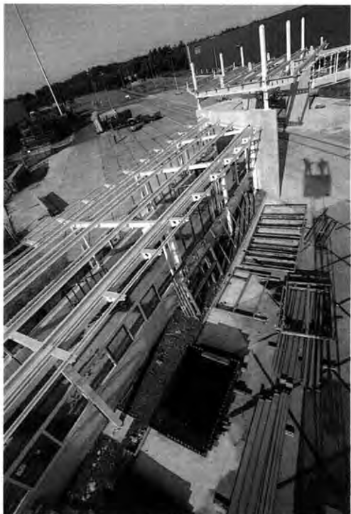
In Bau: Die Verbindung zwischen WVZ und K 30
